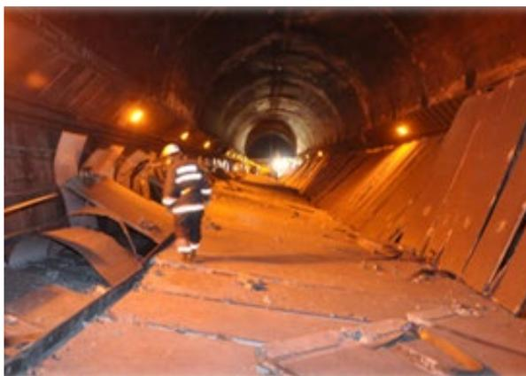
写真-2.1 笹子トンネル天井板落下事故<sup>4)</sup>
