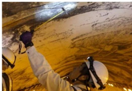
写真-2.3 打音検査作業状況
